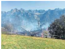
Das Wohnhaus in Flums ist komplett abgebrannt. Bild: Kapo SG
